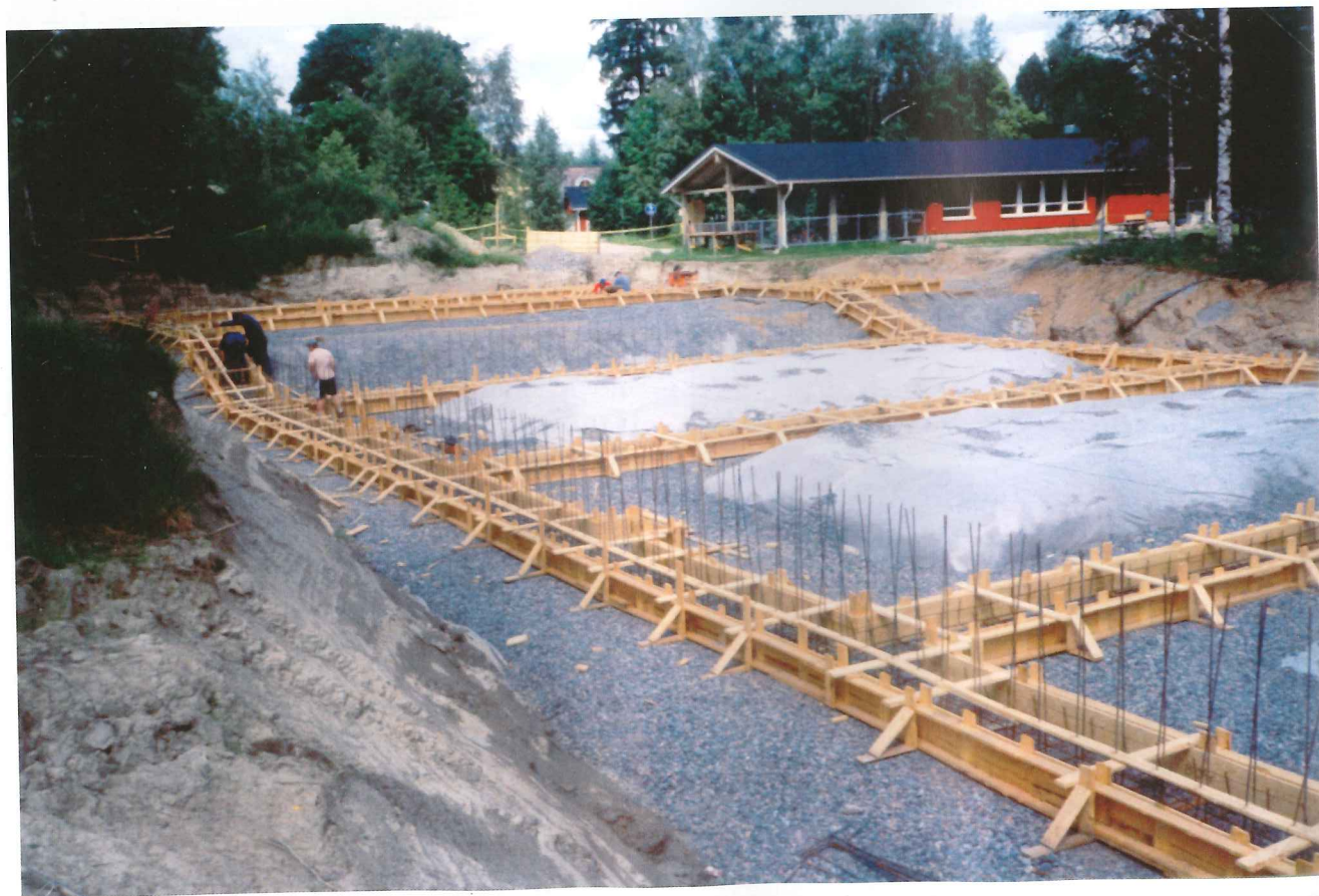
Toisen näyttelyhallin antura valettiin 22.7.2003. Taustalla palvelukeskus.
