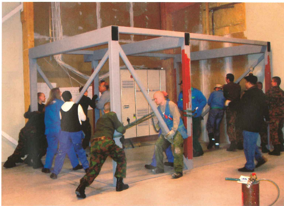
Sähköhuoneen runko hitsattiin kokoon hallissa ja siirrettiin paikoilleen käsivoimin (2005).
