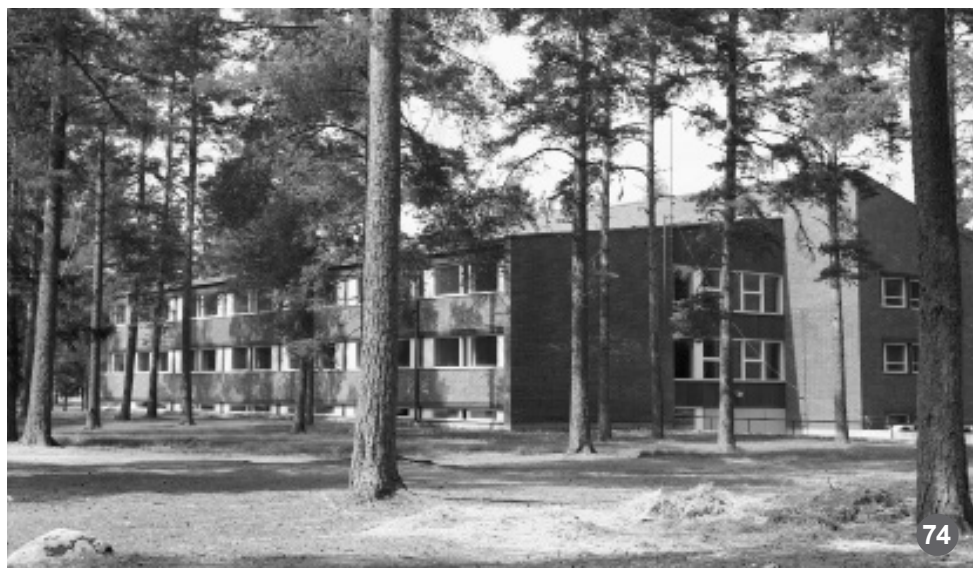
Kuva 74: 1960-luvun alussa Helsingin Ilmatorjuntarykmentille valmistunut kasarmirakennus.
